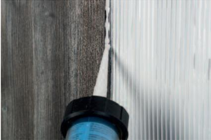
Vor der Verklebung von **RESOPAL SpaStyling® BOARD** auf dem Wanduntergrund müssen alle Bearbeitungsschritte (Zuschnitte, Ausschnitte, Bohrungen, Nutfräsungen etc.) abgeschlossen sein. Erst danach kann mit der Verklebung begonnen werden.
