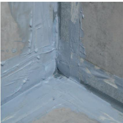
Dichtbänder für Innen- und Außenecken in die noch feuchte Dichtfolie einbetten und direkt erneut überstreichen.
