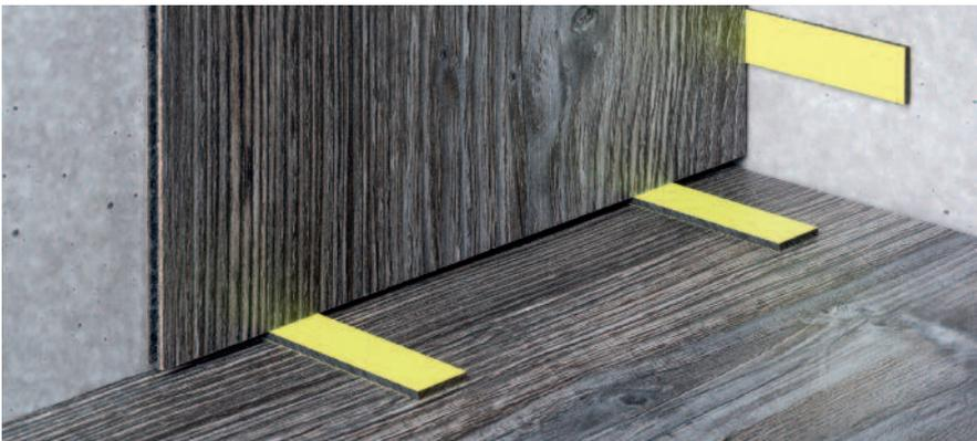
Konfektionierte Boards zunächst trocken (ohne Klebstoff) ansetzen und prüfen. Bitte berücksichtigen, dass zu allen festen Bauteilen (Boden, Decke, Wand etc.) ein Abstand von mindestens 3 mm eingehalten wird.
