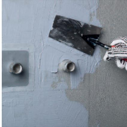
Dichtmanschetten für Rohrdurchführungen in die noch feuchte Dichtfolie einbetten und direkt erneut überstreichen.
